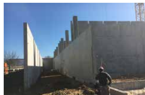
Le chantier Février 2019.
